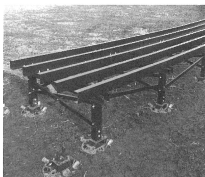
⑤ 桁材の設置 (アルミ合金)
