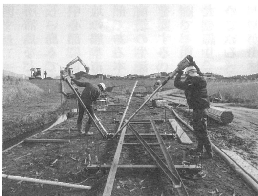
① C-ILESS基礎の設置 (人力での鋼管打設)
