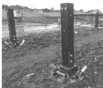
⑤ 桁材の設置 (アルミ合金)
