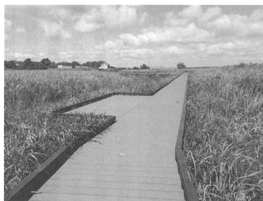
⑥ 完成 (床板設置 合成木材)
