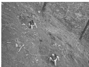
写真5 クリフ基礎設置状況
