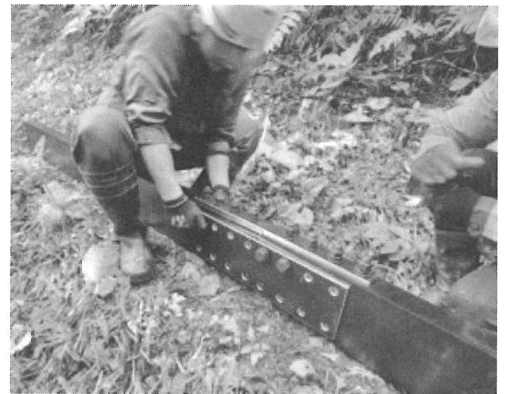
②アルミ合金製の桁を添接する
