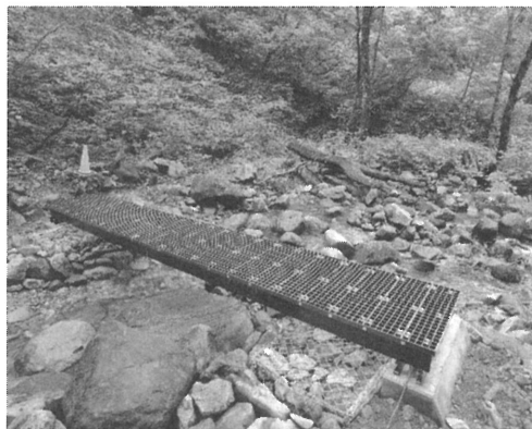
④完成した山岳橋梁
