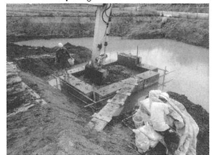
写真1 沈砂池ビオトープでの泥土改良状況
