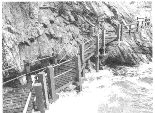
写真2 海浜公園で使用されるFFU橋桁・杭
