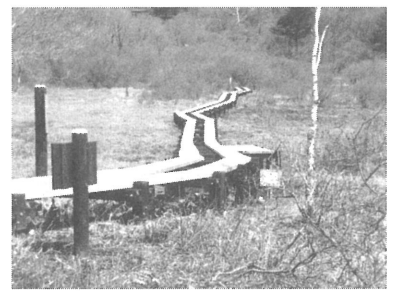
事例1 C-LESS基礎工法を用いた木道
