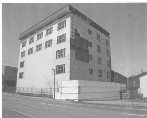
外壁崩落が見られる外観
