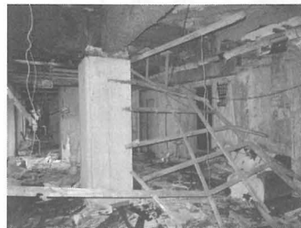
瓦礫類に塞がれた内部通路
