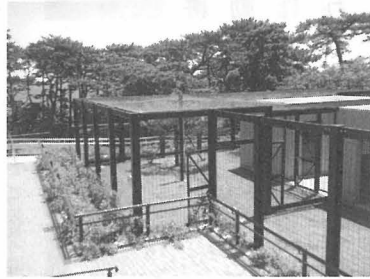
外敵(特にカラス)除け天井ネット設置
