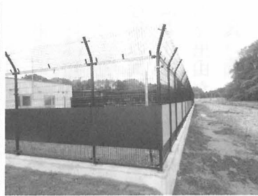
外敵ハクビシン等の爪が掛からないようフェンスに鉄板を設置
