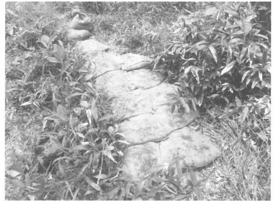
埋設した土嚢
