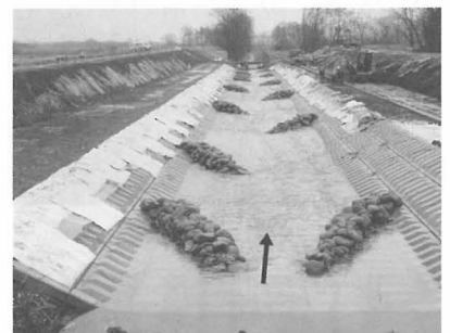
図5 連結玉石のバープ設置(平成21年11月)
