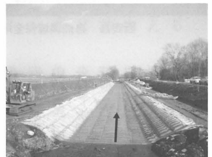
図4 3面張水路完成(平成21年11月)
