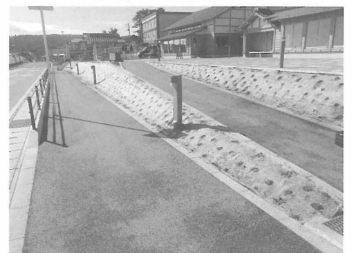
写真6 ポット苗植栽後の法面 (写真後方は種差海岸IC)
