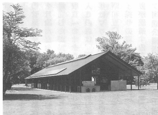
リニューアルした管理棟
