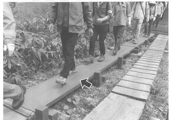
図4 歩廊でのFFU試験採用事例(尾瀬ヶ原の湿原)
