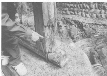
柱下部の腐朽(目視検査)
