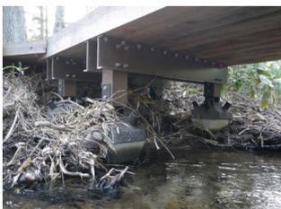
※構造型木道の構造部(支柱・大引)の長寿命化の為にGRPを使用。
