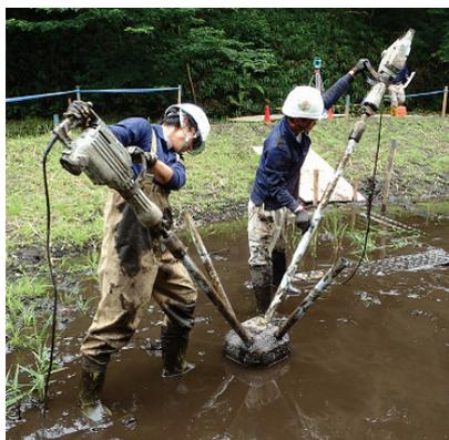
ダイヤモンドピアをガイドにパイプ4本を人力で土中に打込む。
