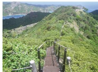
※旭山山頂まで人力運搬する為、運搬コストの縮減で床板にGRPグレーチングパネルを使用。
