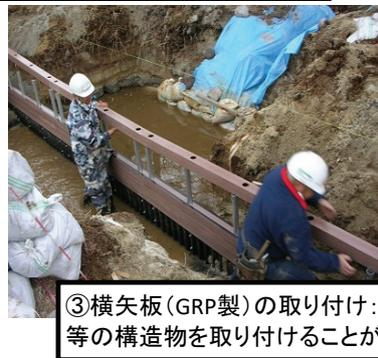
③横矢板（GRP製）の取り付け：必要に応じ、アルミ矢板の上部に横矢板等の構造物を取り付けることができる。
