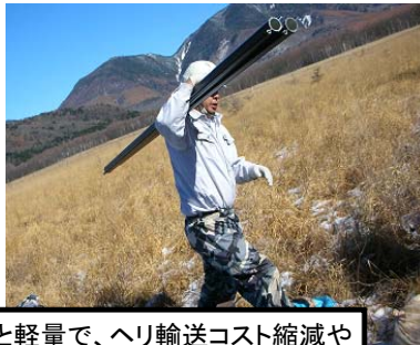
①搬入・運搬：アルミ矢板は2.4kg/mと軽量で、ヘリ輸送コスト縮減や人力運搬の負担を軽減することができます。
