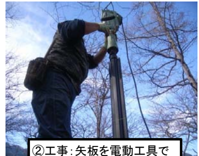
②工事：矢板を電動工具で土中に打込む。
